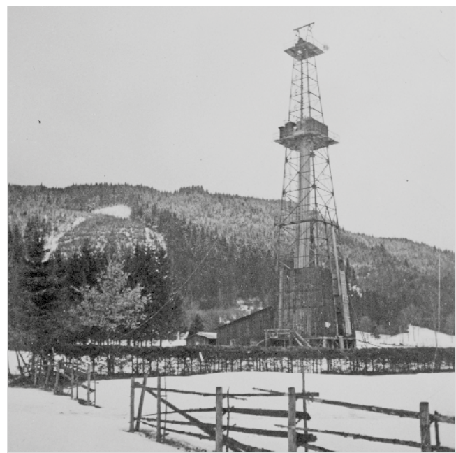
Abb. 5: Die Bohrung „Tegernsee 2“ (Reichsbohrung 429) der DPAG, Januar 1939.
